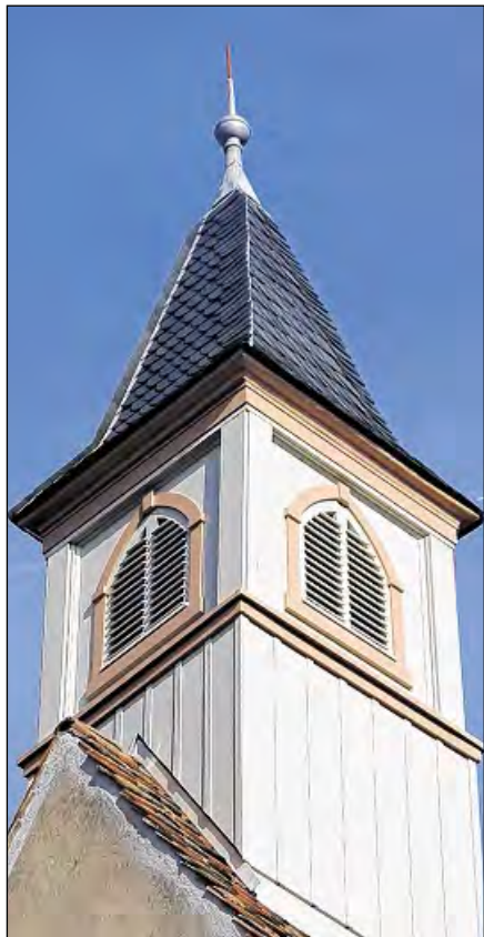
DER TURM der Schlosskapelle in Obergrombach wurde saniert. Foto: kek
