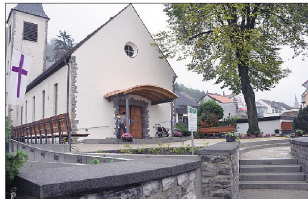
DER KIRCHVORPLATZ der Gustav-Adolf-Kirche in Untergrombach wurde neu gestaltet und jetzt offiziell seiner Bestimmung übergeben. Foto: cha
